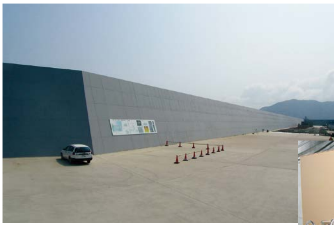
島根原子力発電所の防波壁（最上部は海面から15m）
