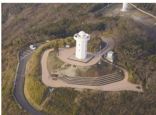
進む上盛山の整備
