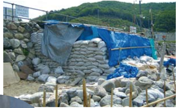
土のうを積み上げた小屋
