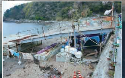
仮棧橋ステップの下にはシーカヤックをはじめ、反対派が様々なものを置いている（4/9撮影）
