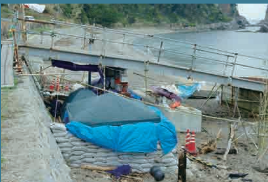
仮棧橋にある反対派のテント（4/9撮影）
