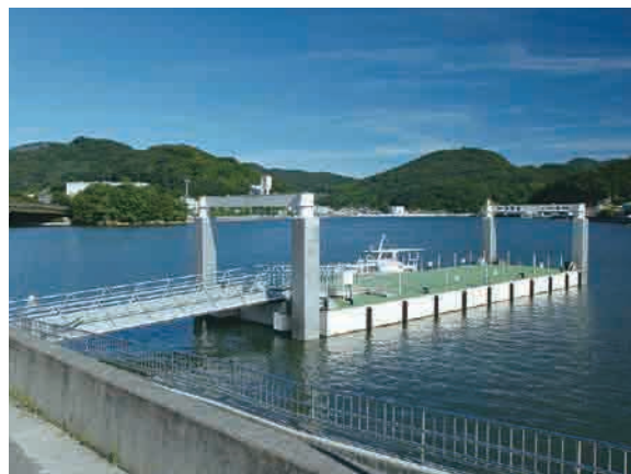
「海の駅」の一般利用者用桟橋
