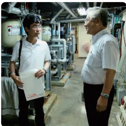
温泉のボイラー室で駅長の杉本清一氏の説明を聞く
