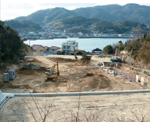
温浴保養施設「上関海峡温泉」建設現場
