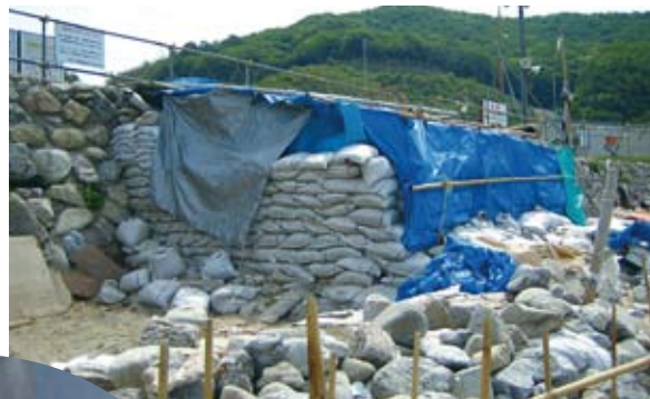
土のうを積み上げた小屋
