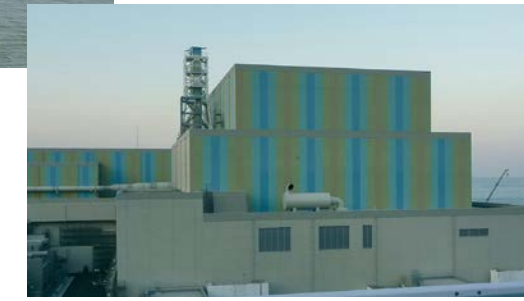
島根原子力発電所3号機
