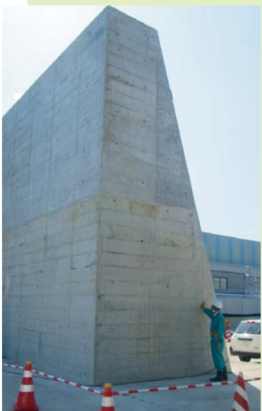
地面との接する部分は4mもの厚みがある
