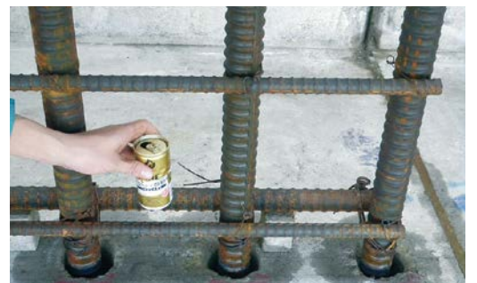
① 直径51mmの太い鉄筋を使用
