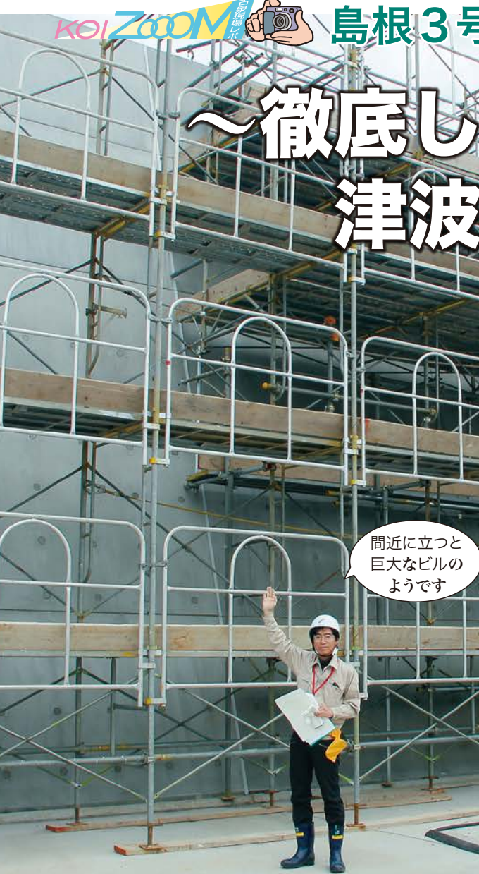
海拔6.5mの地面から立ち上がる防波壁は、全高で海拔15mになる
