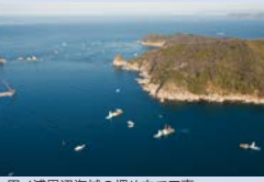
田ノ浦周辺海域の埋め立て工事
