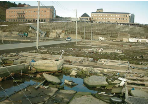
津波に流された女川町の中心部付近 高台にある町立病院の1階まで浸水した
