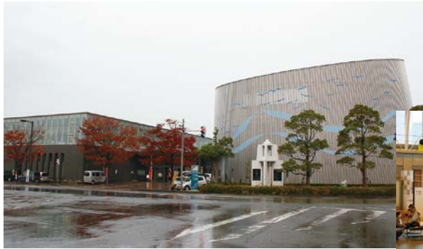
イベントホールや音楽ホールを持つ「きらめきみなと館」
