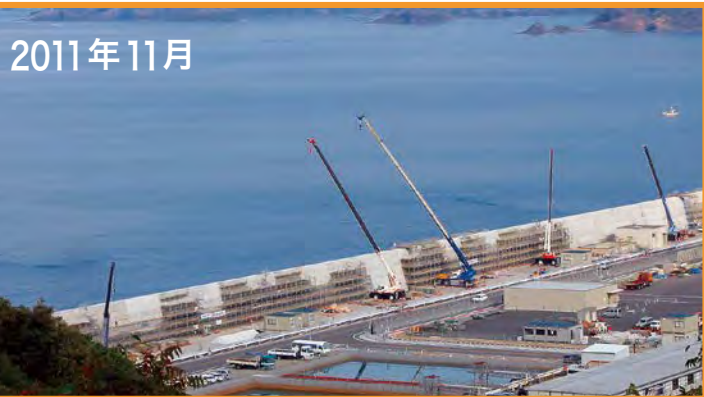
2010年3月時点では防波壁の外側にある消波ブロックが見えていたが、2011年に始まった工事でかさ上げされ、完全に見えなくなっている
