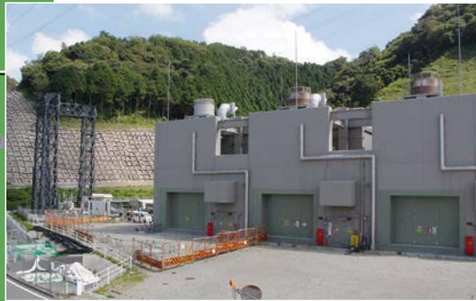
空冷式ガスタービン発電施設（右建物）と耐震性の高い緊急用受電設備（左鉄塔）
