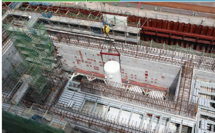
建設中の様子（2020年に撮影）
