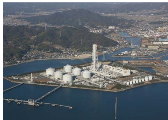
柳井火力発電所(2011年撮影)
