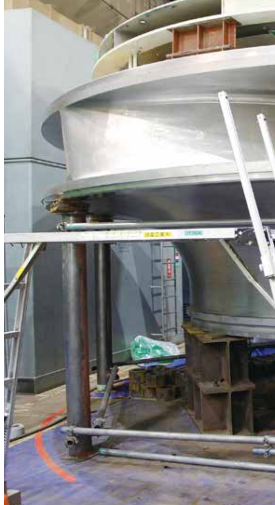
【ポンプ水車】取材の日は2号機が定期点検中で、各種の部品が外写真は73トンもあるステンレス製の水車で、順回転で発電し逆回転
