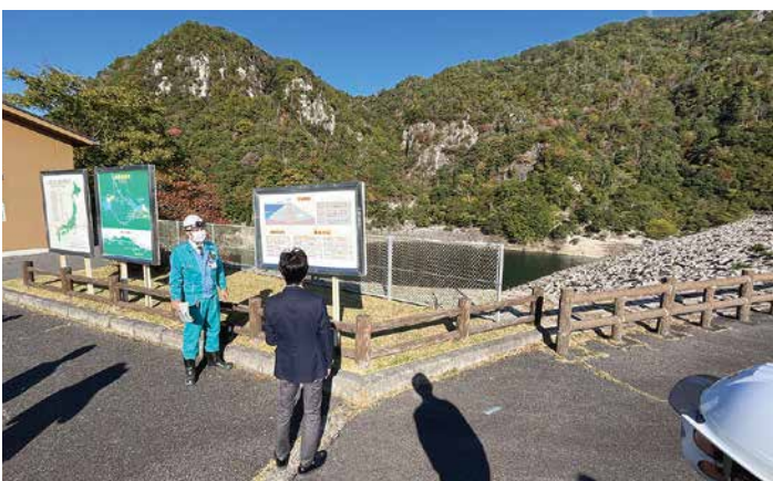
下池の南原ダム(右に見えるのが構造物として積み上げられた自然石)
