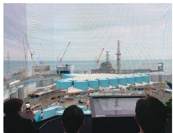
敷地内に並ぶ大量のタンクをモニターで確認
